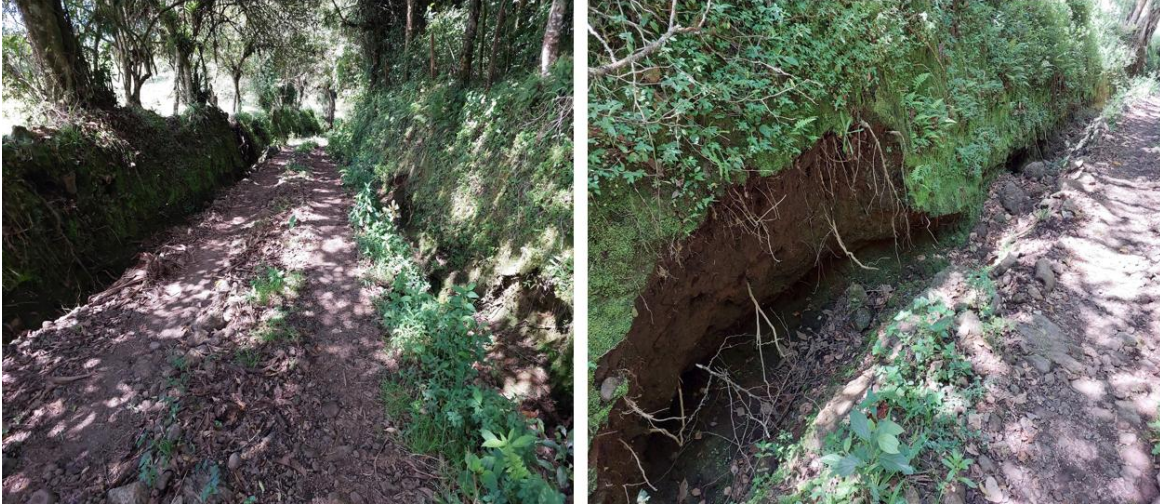
Imagen 12 A lo largo de los caminos la escorrentía forma cárcavas y barrancos que se comportan como torrentes fluviales, erosionando los bordes laterales inestabilizando la red de caminos entre fincas como se nota en este camino cercano a la naciente Carlos Calvo y provocando inundaciones en los poblados de la zona,
