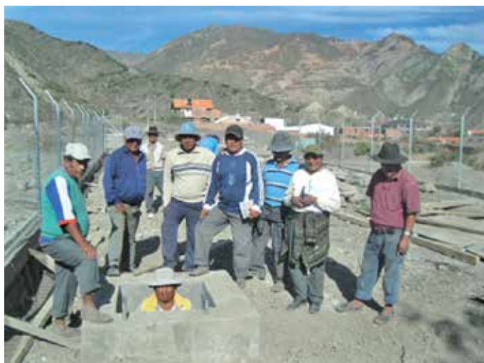
Foto 10: Visita a la planta de tratamiento del sistema de alcantarillado sanitario por autoridades comunales. (D. Lucano, 24 de noviembre de 2017).
