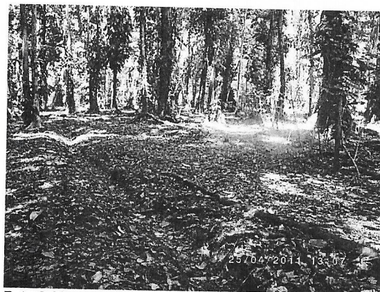
Foto 2. Vista de la una de las zanjas que facilitan el Drenaje o evacuación de las aguas.
